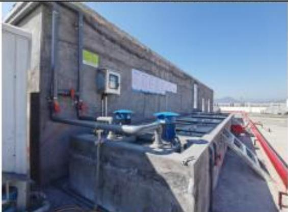
有机废气处理设施(喷淋+干式过滤+活性炭吸附)
