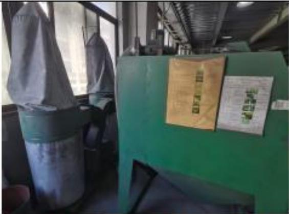
铁边、抛光等机台配套脉冲双筒布袋除尘器
